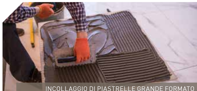
INCOLLAGGIO DI PIASTRELLE GRANDE FORMATO
