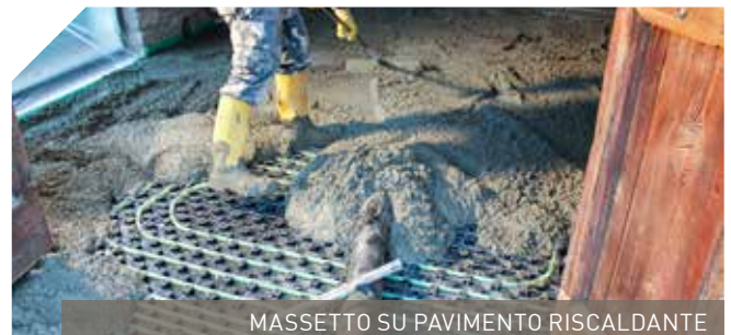
MASSETTO SU PAVIMENTO RISCALDANTE
