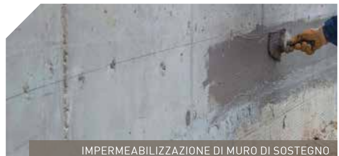
IMPERMEABILIZZAZIONE DI MURO DI SOSTEGNO
