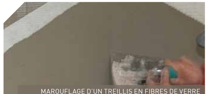
MAROUFLAGE D'UN TREILLIS EN FIBRES DE VERRE
