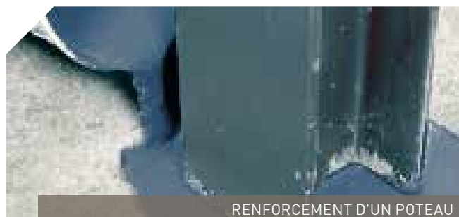
RENFORCEMENT D'UN POTEAU
